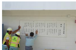
<取り付け工事>
